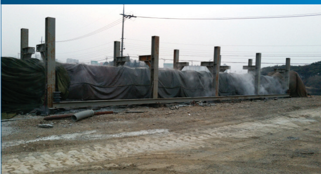
STEP-4. 콘크리트 타설 및 증기양생
