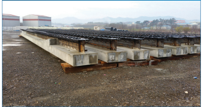
STEP-5. Mono Tendon 긴장 및 이동적치
